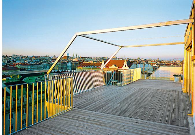
Von gruenhoch3 ausgeführte Dachterrasse mit Eichenboden und maßgefertigten Schienen für eine Segelplane als Sonnenschutz ([www.gruenhoch3.at](http://www.gruenhoch3.at))
